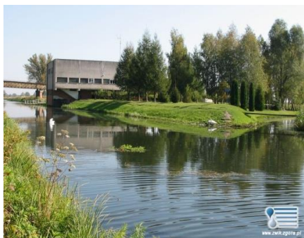
Ujęcie wody w m. Sadowa źródło: www.zwik.zgora.pl
