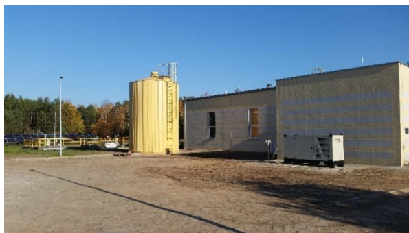
Stacja Uzdatniania Wody w miejscowości Gozdnica, powiat żagański
